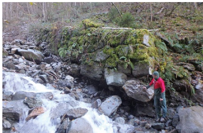
Sous cavage et protection du captage
